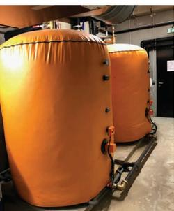
Remplacement des ballons de production d'eau chaude en Résidence et boulevard Montmartre. Présents sur site depuis l'ouverture en 2002, ils ont été remplacés afin d'éviter des fuites, la dégradation des réseaux et une contamination de l'eau (risque de légionellose).
